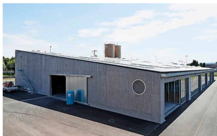
Die Halle des neuen Werkhofes des Tiefbauamts umfasst rund 4000 Quadratmeter Fläche. Foto: Sibylle Meier
